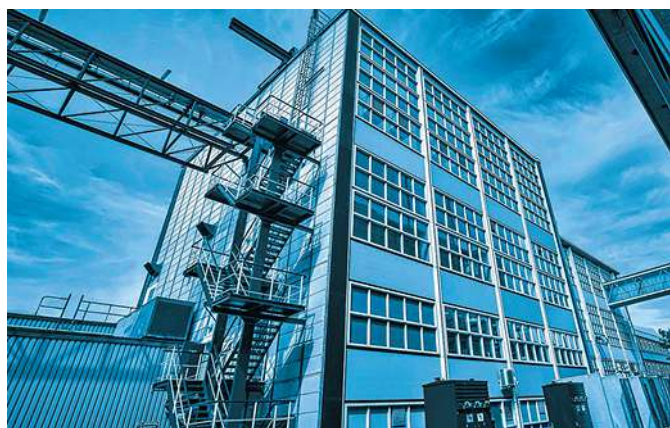
L'usine pilote du procédé CuRe Technology qui doit être opérationnelle à la fin de l'année.
